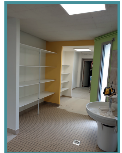
TRAVAUX EN COURS - CHACÉ
